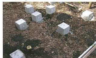
① 整地し、必要な基礎を置く
