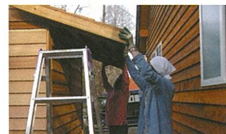
⑥ 屋根パネルを載せる
