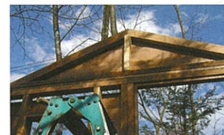
⑤ 妻壁を取付け
