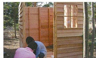
④ 壁パネルを立てる
