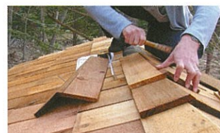
⑦ 棟キャップを葺く
